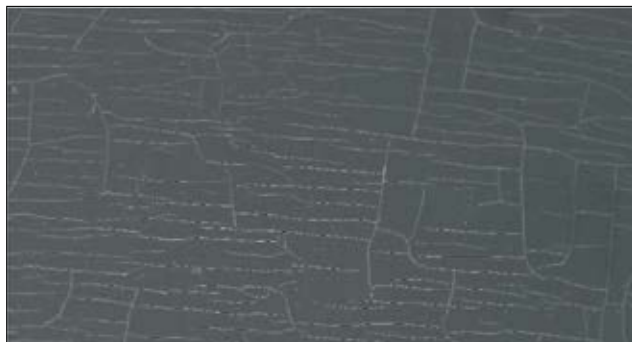
Zaradi UV-sevanja je spoj poškodovan povsod.
