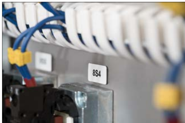
Etichetele pentru tablouri electrice tip Helatag 1220 – adezivul de înaltă performanță asigură o aderență optimă la suprafețele neuniforme.
