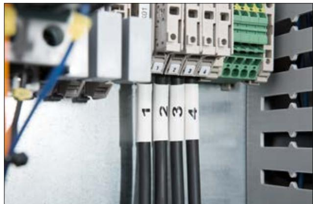
TLFD DS Schrumpfschlauchmarkierer für mehr Sicherheit und Übersichtlichkeit im Schaltschrank.
