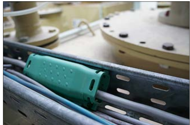
Gel-Kabelgarnitur Relifix V als Kabelverbindung.
