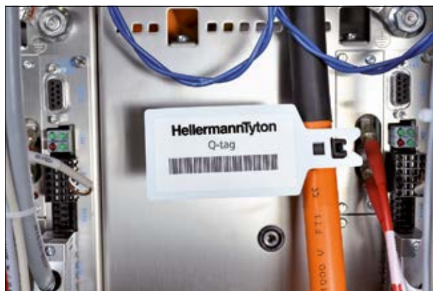
Oznake Q-tag so v obliki zastavic, tako da je besedilo na njih zlahka vidno.
