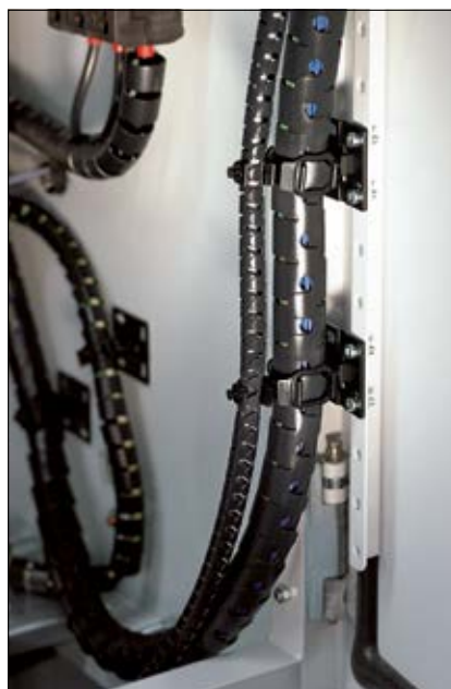
HWPP se běžně používá všude tam, kde je požadována vysoká flexibilita, jako například v oblasti dveří elektroinstalačních panelů.
