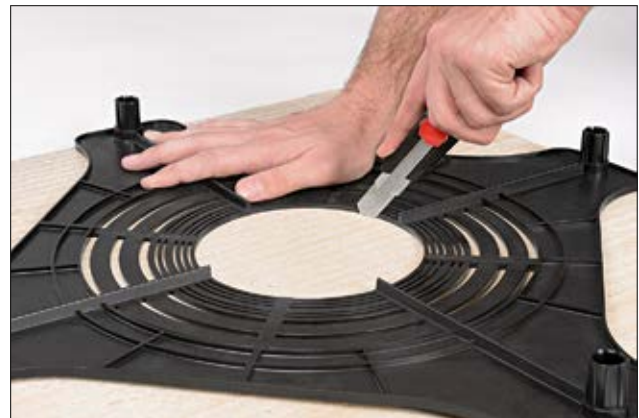
Verwenden Sie SpotClip-Plate als Schablone, um das Befestigungsloch in der Deckenplatte auszuschneiden.
