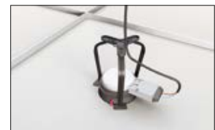
4. Einbaustrahler mit Stromkabel verbinden und Leitung an der Kabelführung befestigen.
