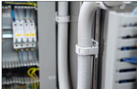
CTCC-IWS Wellrohrhalter und IWS Wellrohr.
